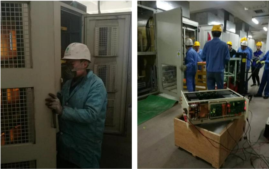
现场深度保养
