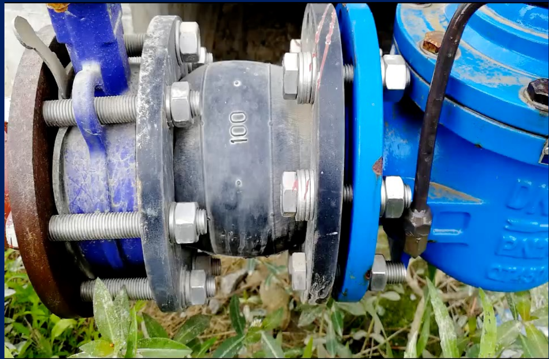
水箱入口处的浮球阀启闭随水箱液位波动而变化
