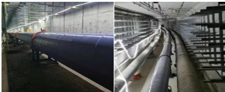
吉林省XX管廊供水管线 DN800 柔性沟槽连接慢转弯
