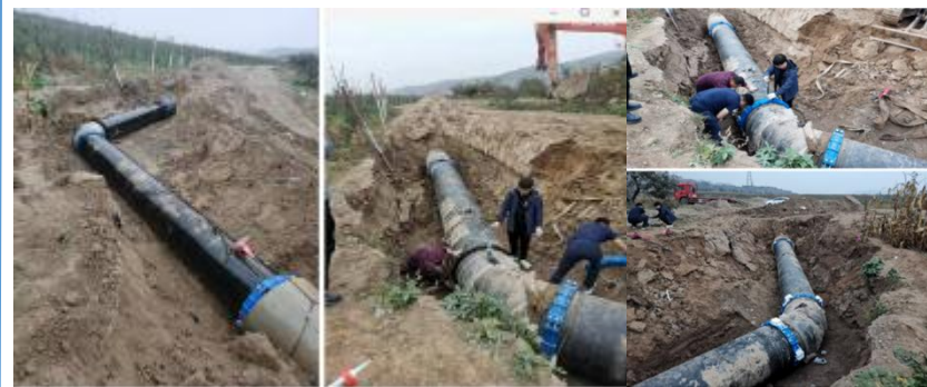
静宁XXX灌区项目 DN800管线
