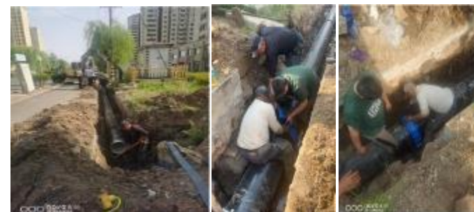
临沂XX老旧管网改造项目 DN400TPEP钢管狭小空间安装
