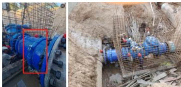
甘肃XX电灌泵站 DN1000法兰连接更换为柔性连接
