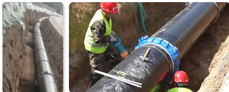
济南城乡供水项目 DN800螺旋钢管 国内首个埋地沟槽连接案例
